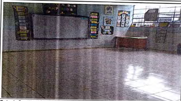
Foto 1: Sustitución de Pisos
