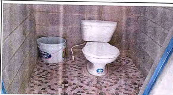
Foto 3: Sustitución de baño
