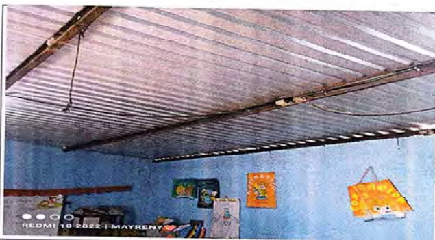
Foto 6 : Sustitución de Láminas
