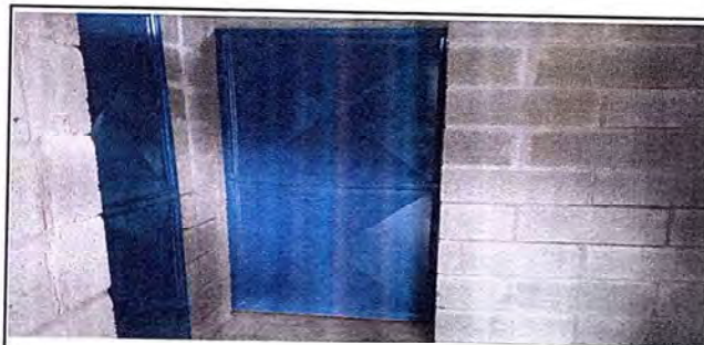
Foto 4: Sustitución de puertas
